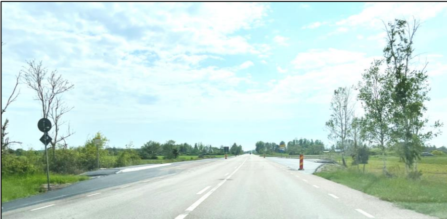
Figur 7. Väg 136 vid korsningen Djupviksgatan 2024 med nyligen ombyggd busshållplats. Vy söderut.
