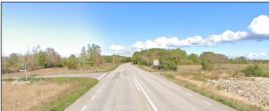
Figur 6. Väg 136 vid korsningen Djupviksgatan. Vy norrut. Källa: Google Maps (2023).
