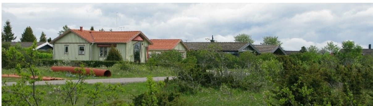
Fig.37. Fritidshus/villor från omkring 1980 i den norra delen av delområdet.
