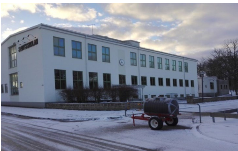
Tillfällig nödvattentank uppställd på grund av vattenläcka.
