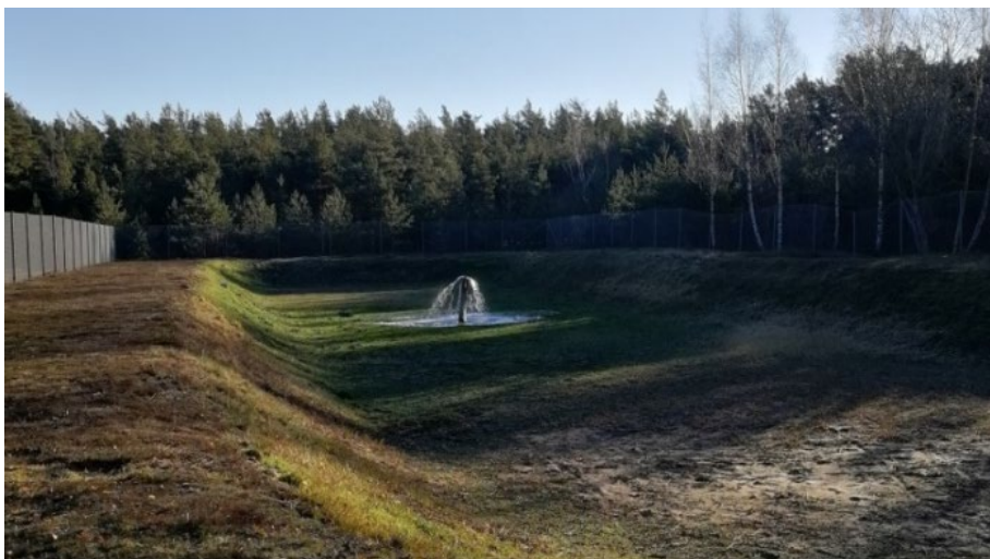
Infiltration av ytvatten vid Solbergafältet.
