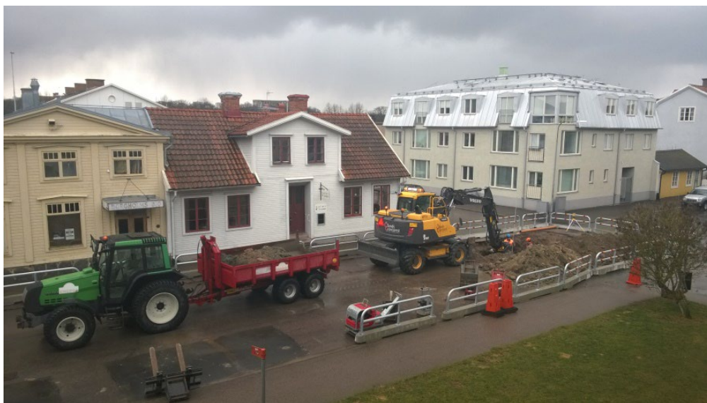
Arbete på ledningsnätet i Borgholms stad.
